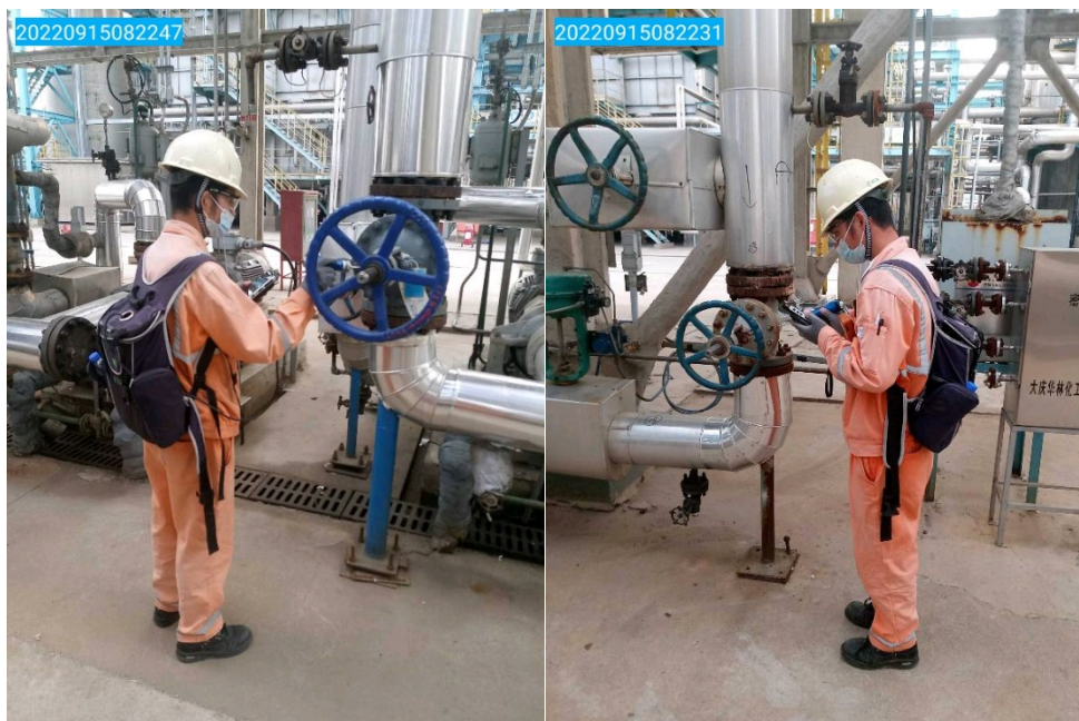
图 4-4 现场检测图片
