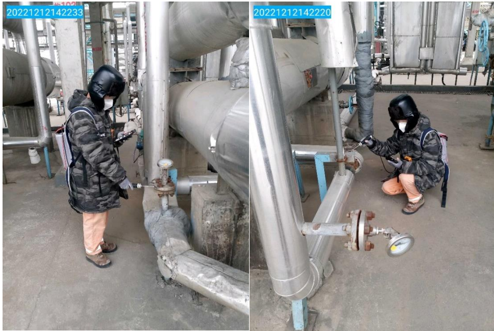
图 4-4 现场检测图片
