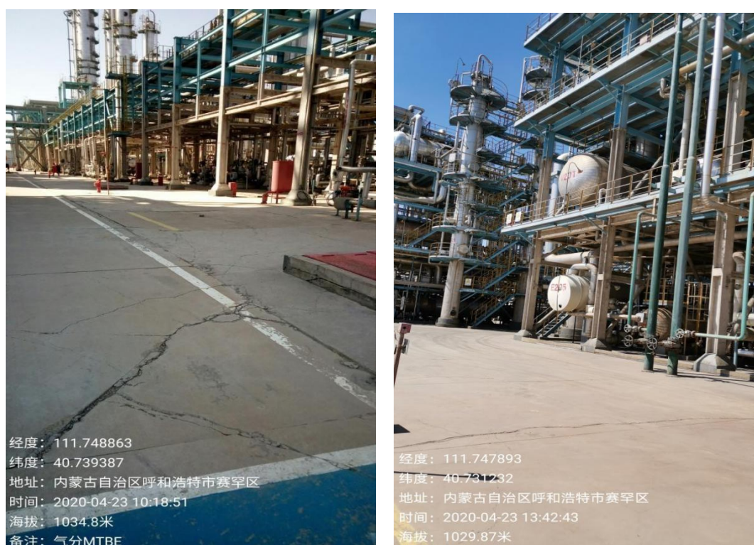
图5.4-1 A 区 现场情况照片
