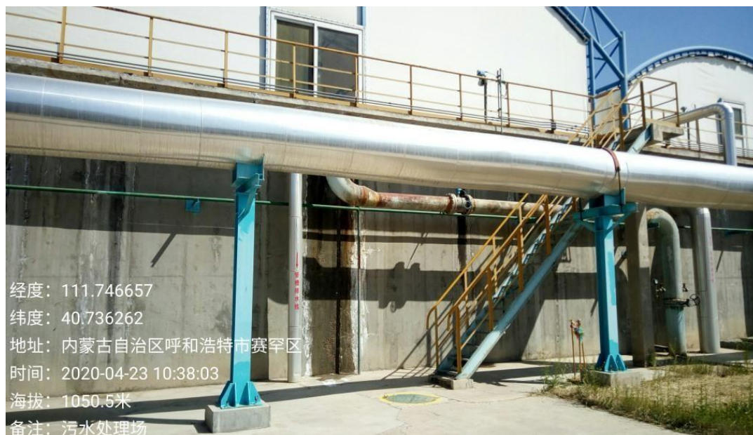
图5.4-2 D 区现场情况照片
