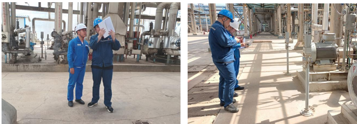
图5.2-1 现场踏勘照片
