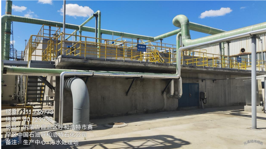
图5.4-2 G 区现场情况照片
