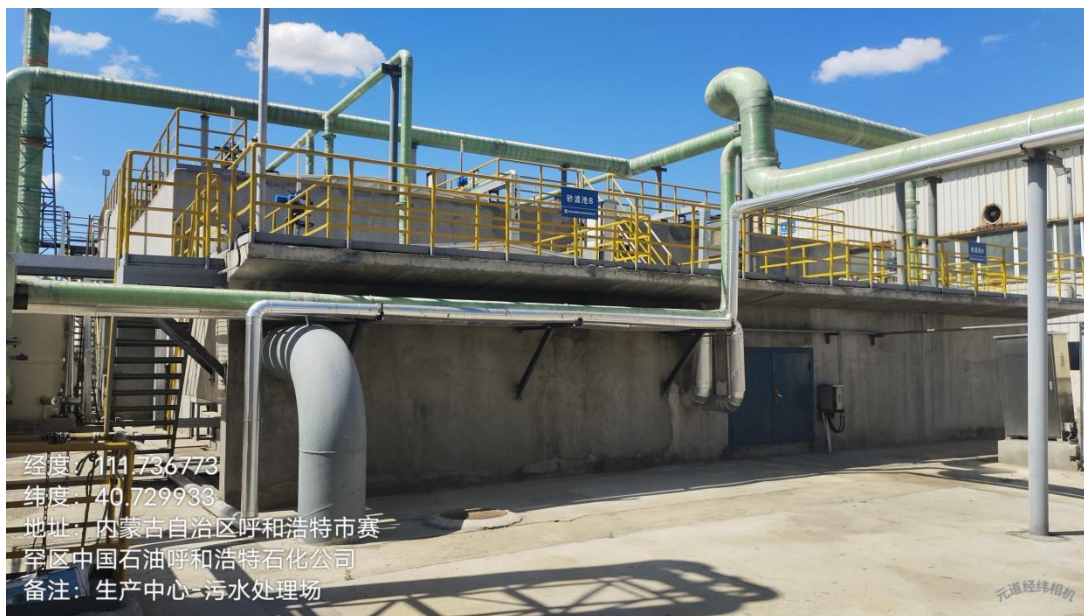
图 2.4-2 G区现场情况照片
