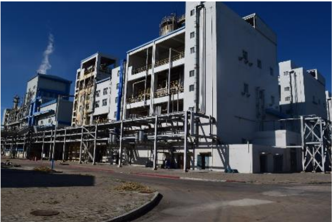
图 2.4-1 A 区现场情况照片
