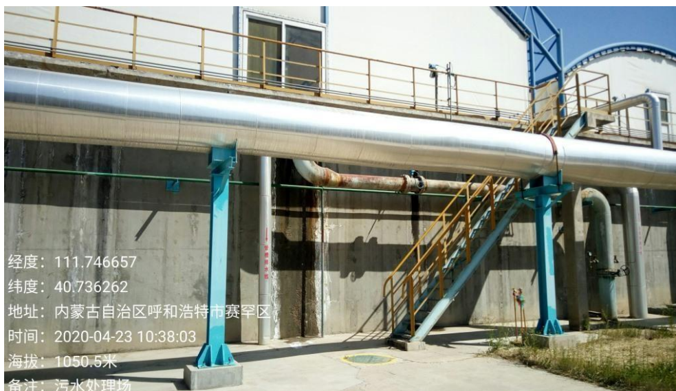
图 2.4-2 D区现场情况照片
