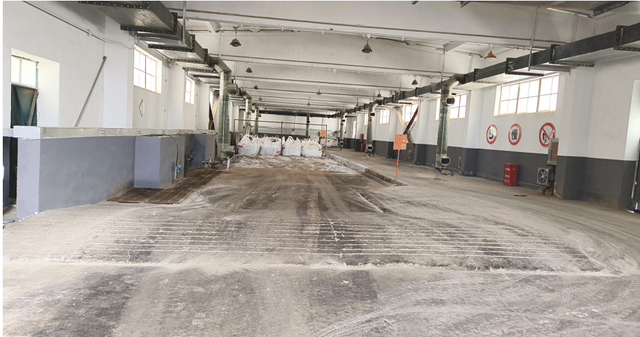
危险废物暂存库内部设施
