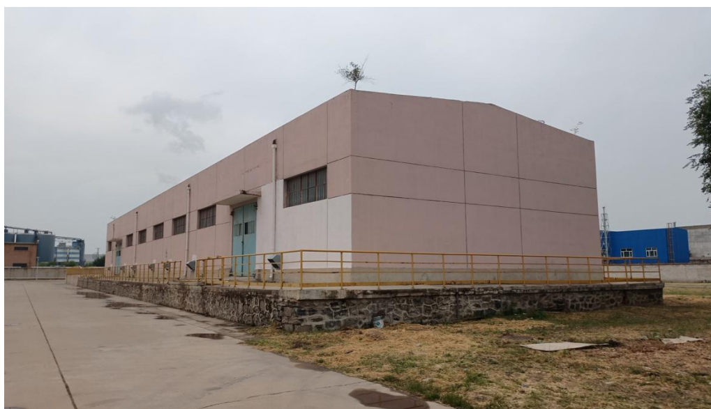
图2.4-5 L区现场情况照片
