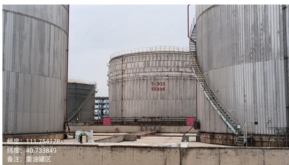
图 2.4-3 G区现场情况照片
