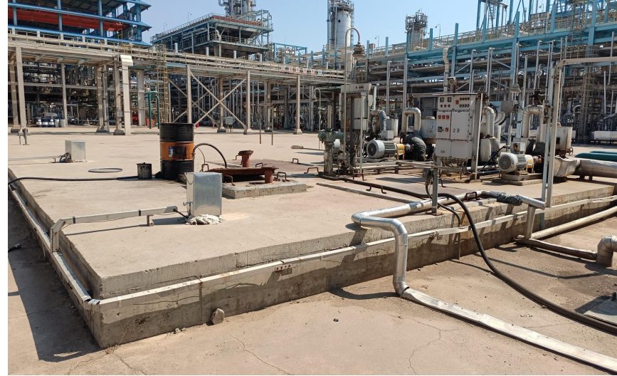
地下半地下池体
