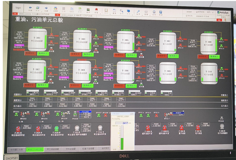
储罐液位计数据显示
