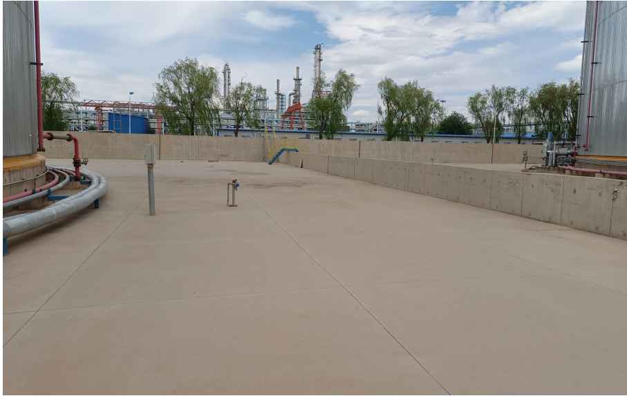
罐区内地面硬化处理
